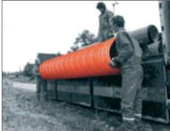
3 pav. Vamzdžių krovos darbai
